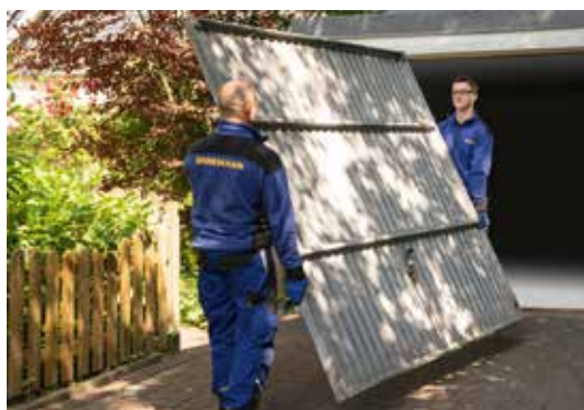
Ausbau und umweltgerechte Entsorgung
